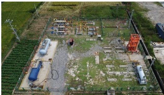
采气井场现状
